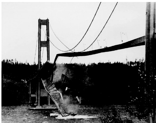
图5 海湾强风引起桥面和桥体共振而造成断裂的西雅图(旧)Tacoma Narrows Bridge吊桥
