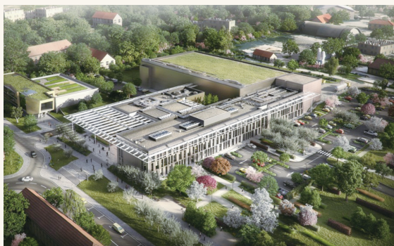
图2 捷克首都布拉格的ELI-Beamlines Facility [12]
