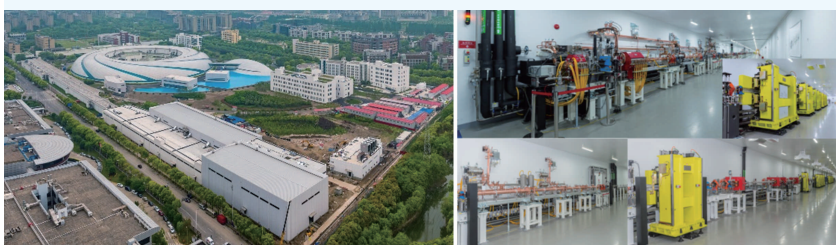
图7 SXFEL建筑鸟瞰图(左)与试验装置注入器、主加速器和FEL放大器(右)
