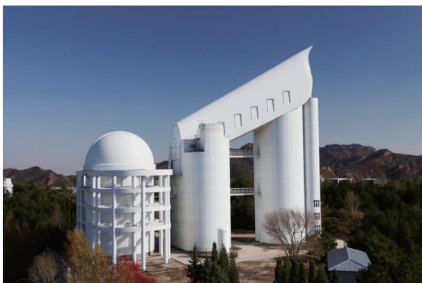
图1 LAMOST望远镜全称大天区面积多目标光纤光谱天文望远镜,是我国自主创新设计、同时兼备大视场和大口径的光学天文望远镜。焦面上共有4000根光纤,可同时接收最多4000个天体的光谱,为目前世界上光谱获取效率最高的望远镜
