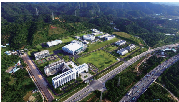
图1 中国散裂中子源航拍图
