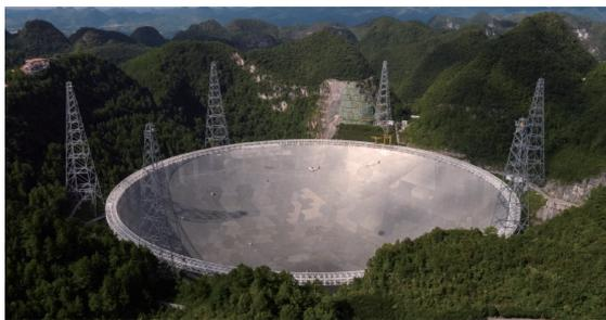
图3 FAST高精度馈源支撑系统采用刚柔两级调整机构，是FAST三大自主创新之一，为世界首创。图中间设备是世界上最大的、跨度达600 m的柔索并联机器人，可以牵引重达30吨的馈源舱
