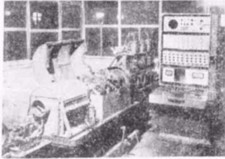
图 12 探伤仪和主传动装置(主机)
