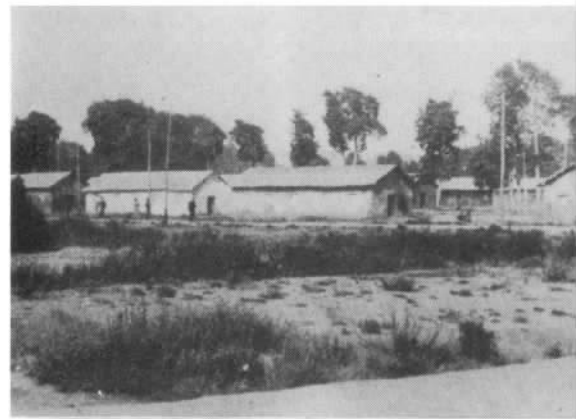
图4 西南联合大学校门、学生宿舍及图书馆缩小照片
