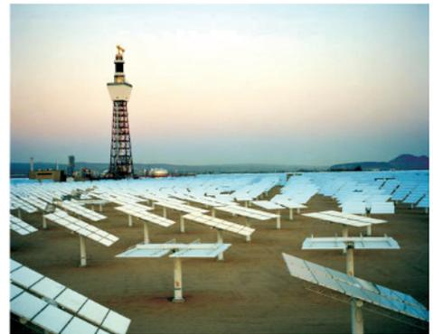
图2 塔式太阳能热发电站
