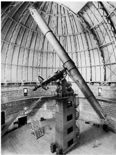
图 4 1897 年在叶凯士天文台落成的口径 1.02m 的折射望远镜
