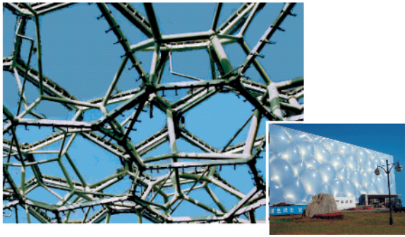
图 16 水立方的骨架结构,其间将镶嵌 ETFE 膜气枕,右侧图是铺设好 ETFE 气枕后的水立方外景(摄于 2007 年春)
