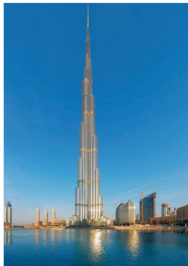
图 2 花费 5 年时间于 2010 年 1 月建成的哈利法塔位于阿拉伯联合酋长国的迪拜城.塔高 828m 是世界上最高的一个建筑.为了降低旋涡脱落相干性对该塔的伤害,设计师们沿着建筑物的高度从上到地改变了横截面的大小.为了纪念阿拉伯联合酋长国的总统哈利法,将此塔命名为哈利法塔
