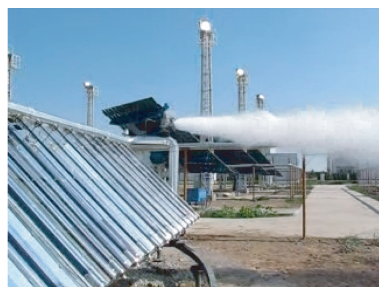
图6 能连续发出中温蒸汽的蒸汽发生器照片
