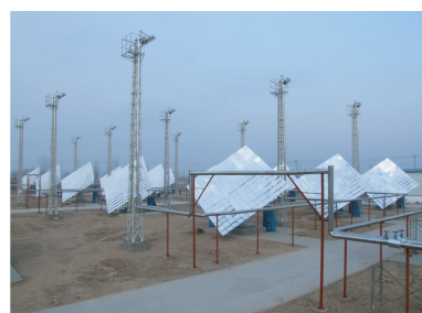
图 4 一组“定日镜+集热面+小塔”联合集热照片
